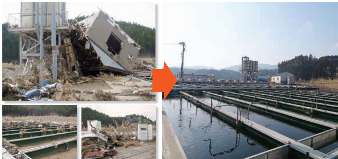
被災後の状況
